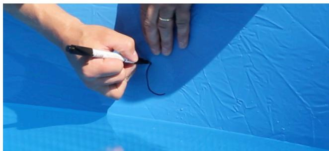
Merkitse/piirrä aukko altaan vuoraukseen ja leikkaa sen jälkeen ympyrän keskelle rasti terävällä veitsellä. (Kuva 4). Älä viillä altaan seinää ympyrän ulkopuolelta. Sijoita paluuhde (10) ja tiiviste (11) altaan sisäpuolelta altaan seinän läpi. Kiinnitä paluuhde altaan seinään kiristämällä muovimutteri (12) hyvin. Älä kiristä mutteria liian tiukalle.
