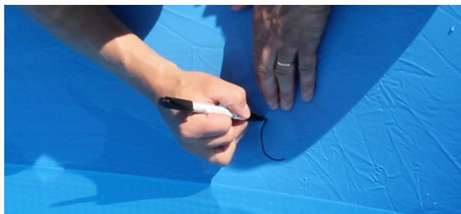
Joonistage/märkige voodrisse ümmargune auk ja lõigake seejärel terava noaga ringi sisse X. Ärge lõigake märgistatud auguservast üle. Nüüd paigaldage tagasivoolutoru (11) ja tihend (12) seestpoolt basseini ja läbi basseini seina. Kinnitage tagasivoolutoru basseini seina külge, keerates plastmutri (13) kindlalt kinni. Ärge pingutage mutrit liiga palju.
