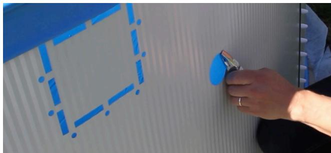
Den Beckenwandausschnitt für den Skimmer und die Düse sollten Sie vor der Folienmontage durchführen. Die Ausschnitte sollten mit einer Feile entgratet werden und zusätzlich mit Anti-Korrosionsfarbe behandelt werden. Als zusätzlichen Schutz empfehlen wir Ihnen, die Kanten mit Isolierband abzukleben.
