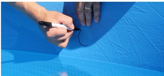
Tegn/merk av det runde hullet i innerduken og skjær deretter et kryss i sirkelen med en skarp kniv. Unngå å skjære utenfor det merkede hullet. Plasser returløpet (11) og en pakning (12) fra innsiden av bassenget og ut gjennom bassengveggen. Fest returløpet til bassengveggen ved å skru fast plastmutteren (13). Ikke trekk mutteren for hardt til.
