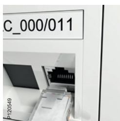
P120549 Liittimet käännetty johtojen irrottamisen helpottamiseksi.
