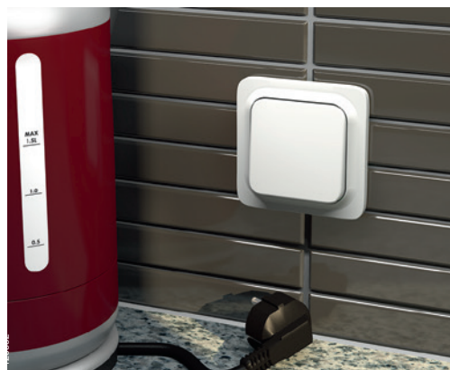
Vanha asennus, jonka paikalle tarvitaan uusi pistorasia.
