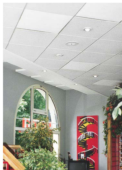
Värdefulla vägg- och golvytor hålls fria då värmestrålaren placeras i taket.
