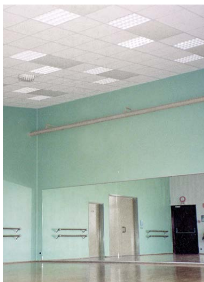
Thermocassette ger behaglig värme på golvet i utrymmen där du kanske vill gå barfota.
