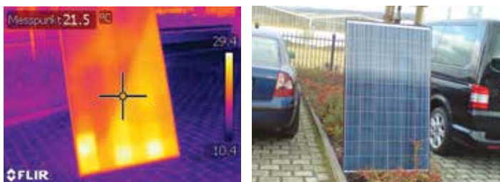
Ett test med en solcellspanel visar att varmgångarna enkelt går att se i värmebilden till och med från framsidan.
