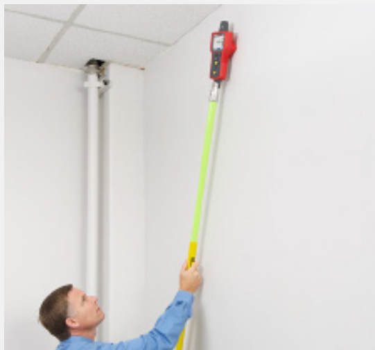
Spåra ledningar på svåråtkomliga ställen med isoleringsstav.
